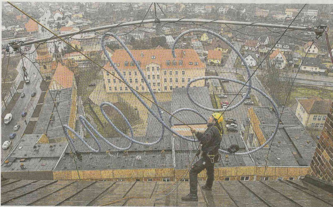
Dachdeckermeister Michael Schwarz aus Fürstenwerder seilt sich in etwa 50 Meter Höhe zwischen den Türmen der Kirche ab, damit das Netz mit der Lichtinstallation in das Tragwerk an der Kirche eingehängt werden kann.
